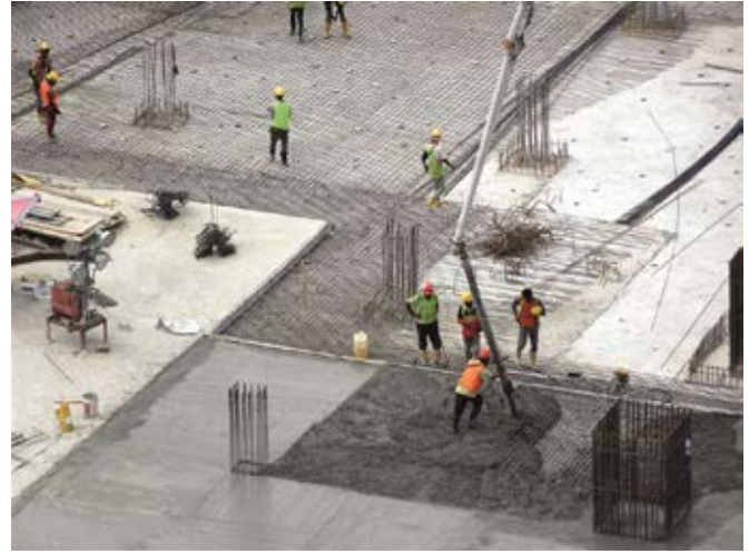
Kuala Lumpur, Malezya'da büyük bir beton dökümü
