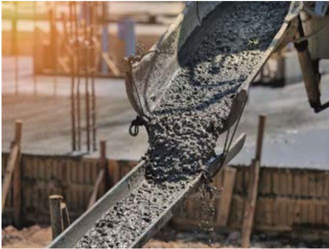
Sahadaki bir transmikserden beton dökülüyor
