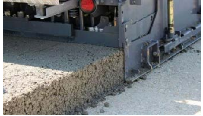
Şekil 6: Silindire Sıkıştırılmış Beton
