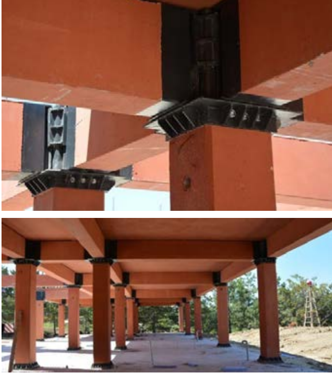
Şekil 3. İYA-esaslı malzemelerin sökütüp-takılabilen yenilikçi üretim tekniğinde kullanımı
