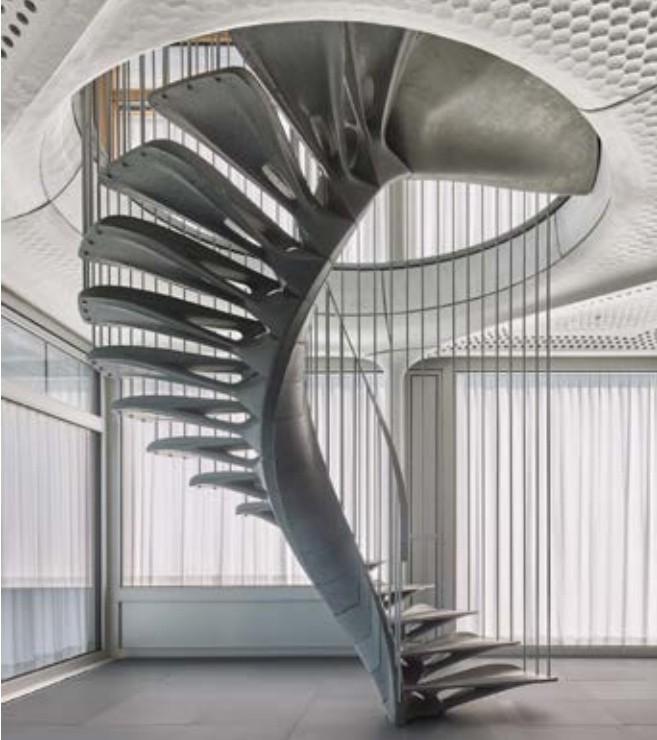
Cadenza, malzeme azaltımı ve döngüsel ekonomi düşünülerek tasarlanmış bir beton merdivendir.
